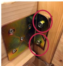
左図のように、サイドフレームを引っかけます。四カ所ひっかけたら、レンチもしくはドライバーでネジをしっかりと締めてください。
